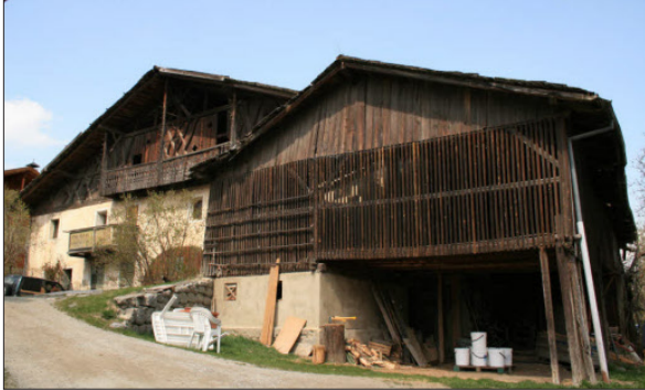
Huberhof vor dem Umbau
